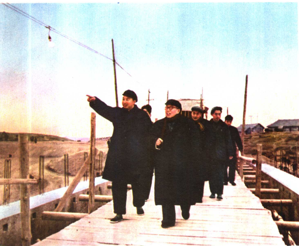
华国锋同志和谭震林同志视察正在施工中的韶山灌区工地
