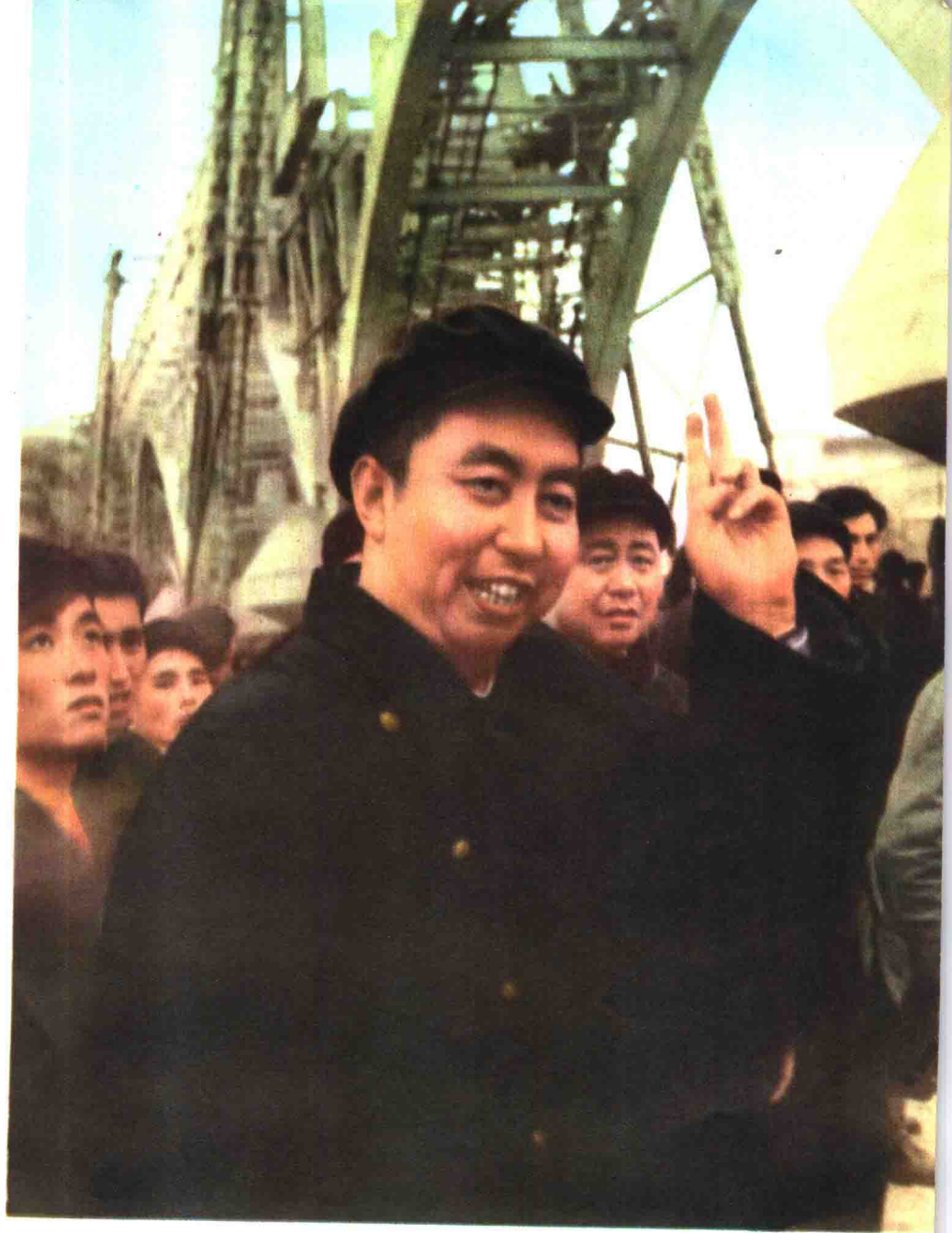
华国锋同志亲自指挥“飞涟灌万顷”渡槽的吊装施工
