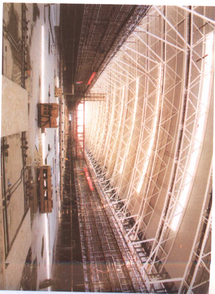
施工中的办票大厅
