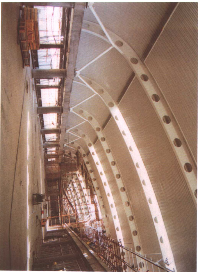
施工中的候机大厅
