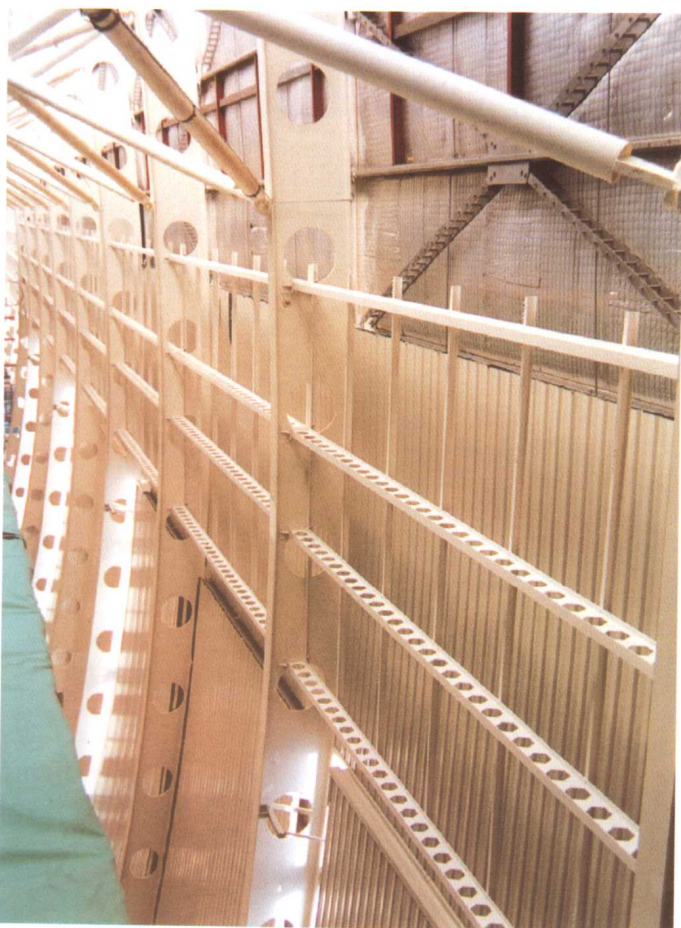
三层浮云吊顶骨架
