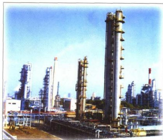
安庆石化总厂400kt/a催化裂解装置 (1997年荣获国家建筑工程鲁班奖) 项目经理:彭人元
