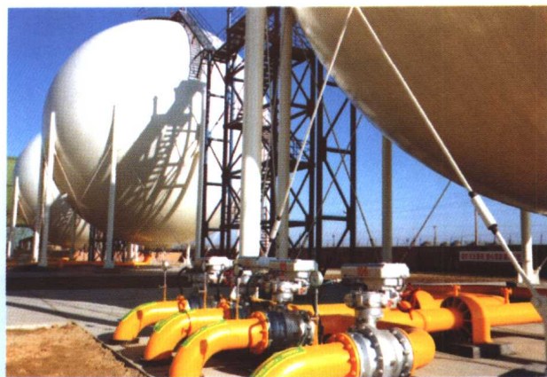
公司承建的天津市陕津天然气集输5台/5000m 3 高压储罐工程
