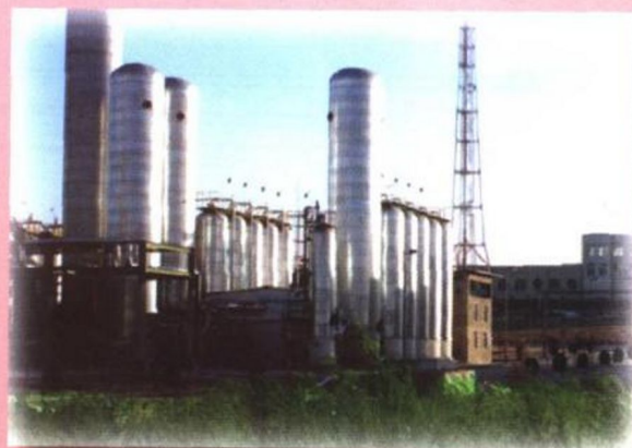
辽阳化纤厂 4 万 \text{Nm}^3/\text{h} 变压吸附提纯 \text{H}_2 装置
