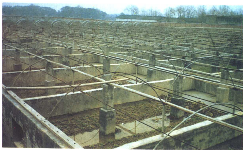
图 10 多棚多池方阵组合式塑料棚温室
