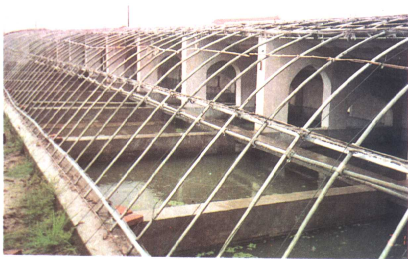
图 8 管架组装式塑料棚温室
