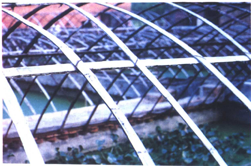
图 9 竹木结构塑料棚温室
