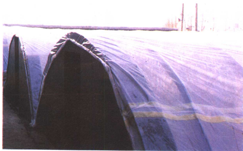
图 14 山墙式棚头塑料棚温室
