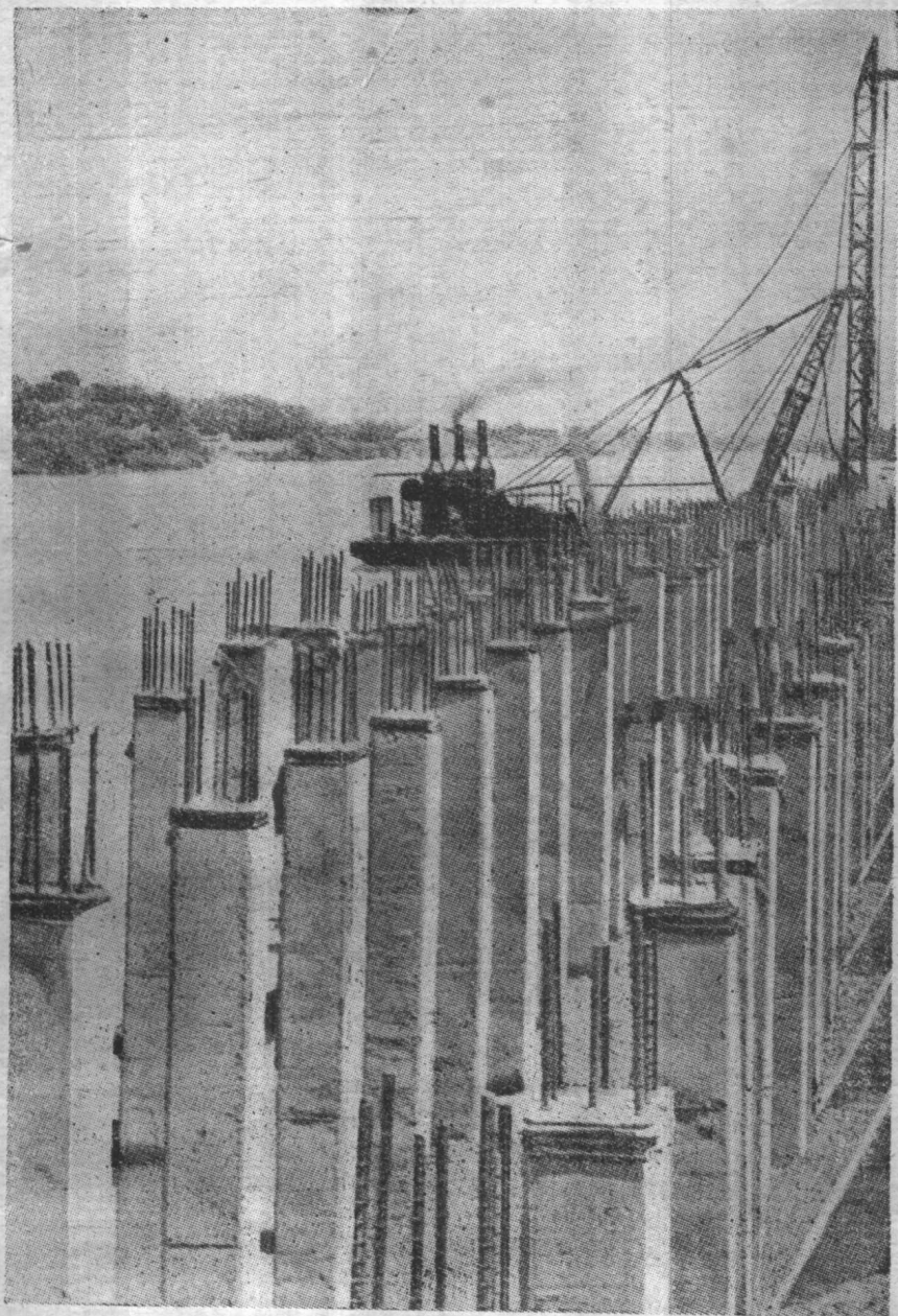
施打碼頭鋼筋混凝土基樁
