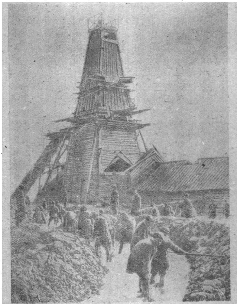
图 1 石油噴井旁的修筑工作
