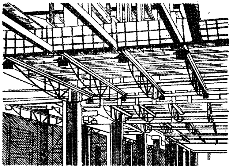
圖2 莫斯科高大建築物之一，其層間樓蓋所用的吊掛模扳
