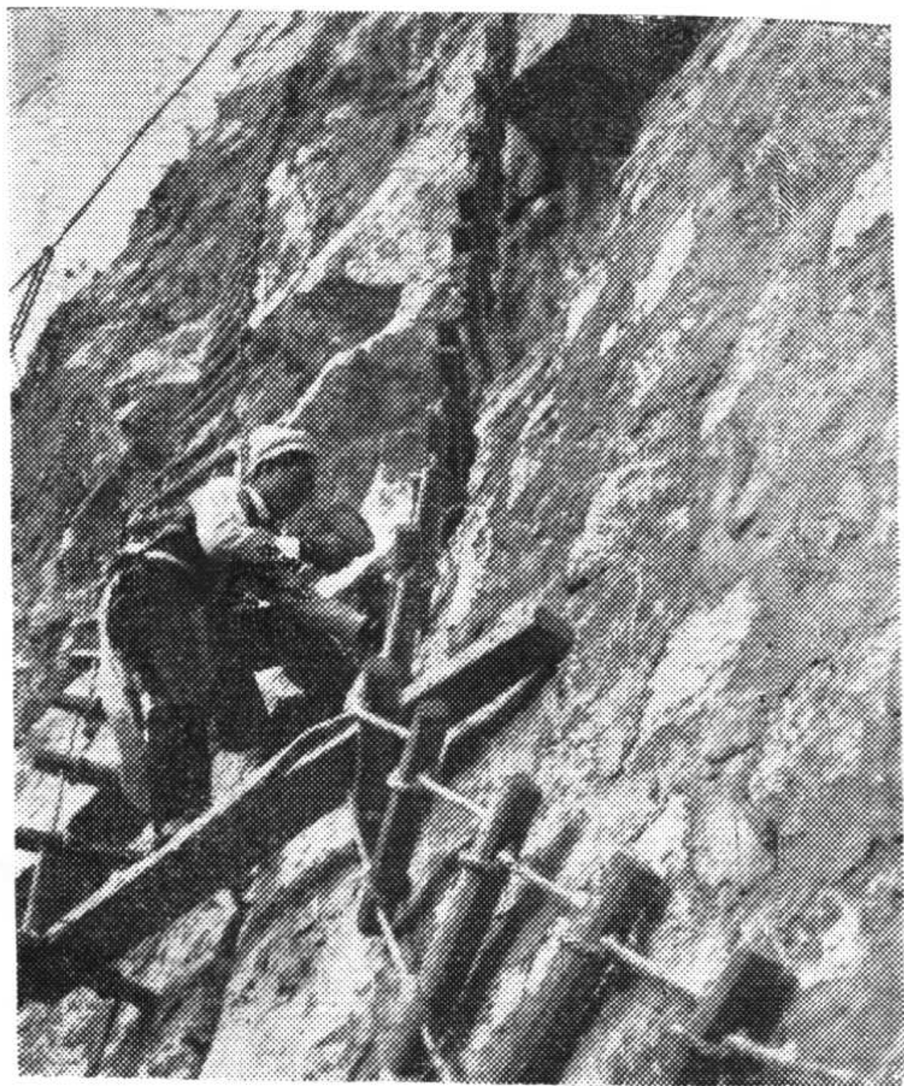
照 6-5 在边坡上进行挖补
