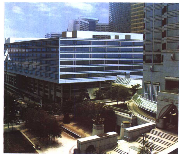
太阳信托投资广场花园办公楼
