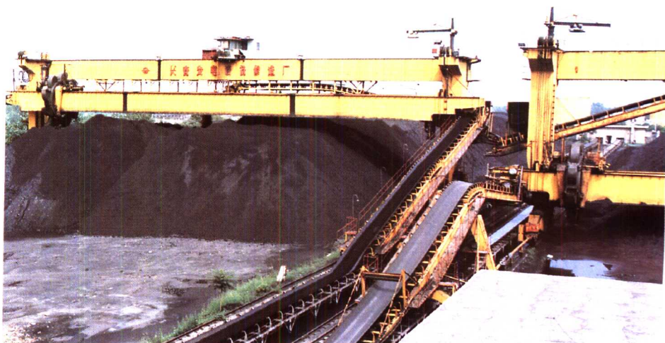
3、4号机组贮煤场
