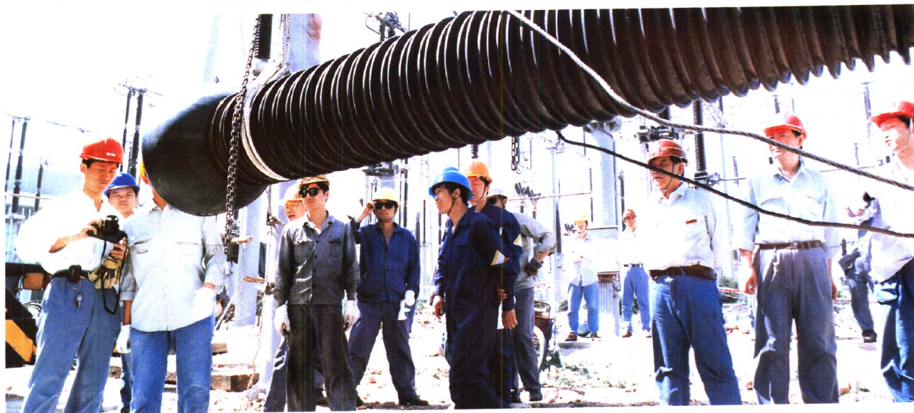
检修 500 千伏变电站
