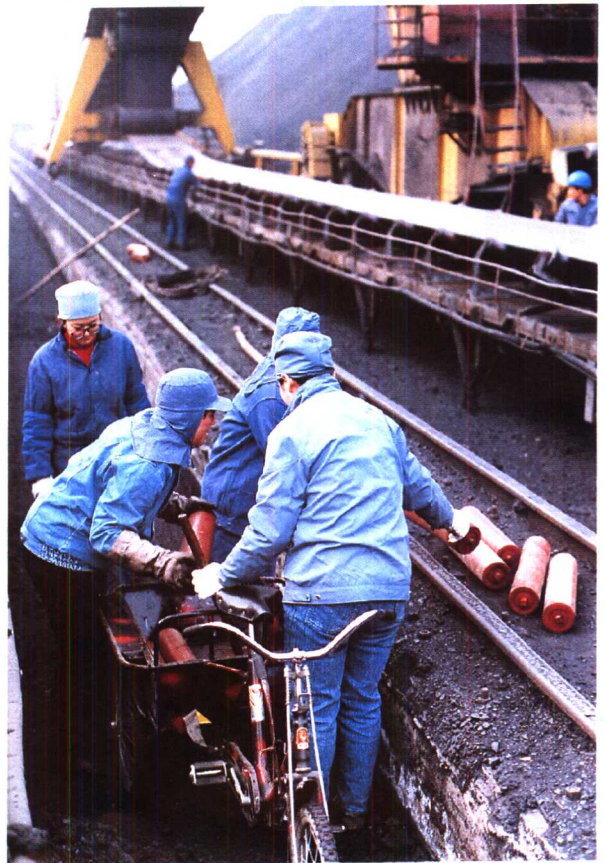
检修输煤皮带
