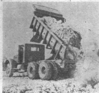
圖 1-5 25 噸傾卸汽車卸料時情形
