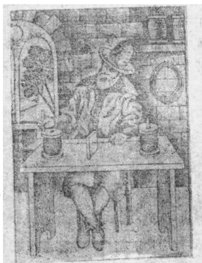
图4 通过从一个线轴重缠到另一线轴拉伸细线
