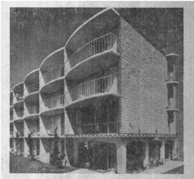
图 1-4 用承重混凝土砌块建成的低层住宅建筑
