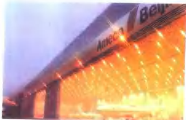
左图：首都机场的第四机位机库，目前，它是亚洲最大的机库
