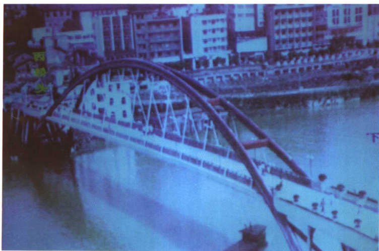
图30 垮塌前的虹桥
