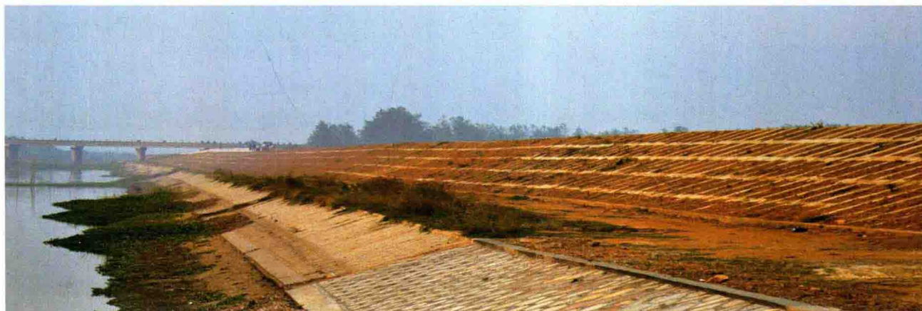
王大圩堤外坡护坡工程
