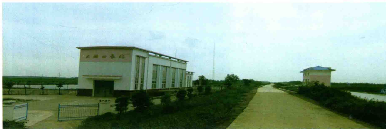
2009年10月竣工的新大湖口电排站
