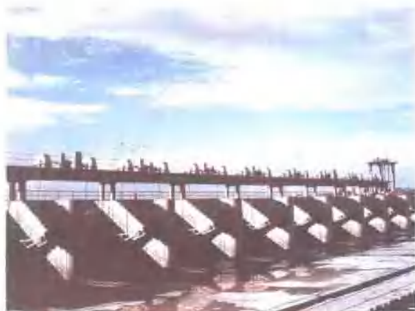
阿克苏地区西大桥水电站冲砂闸(装机 1.3 万千瓦)
