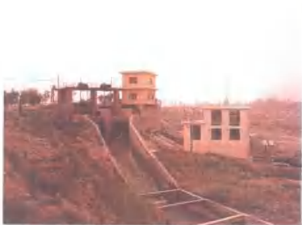
喀什地区勿南渠三级水电站(装机 0.13 万千瓦)
