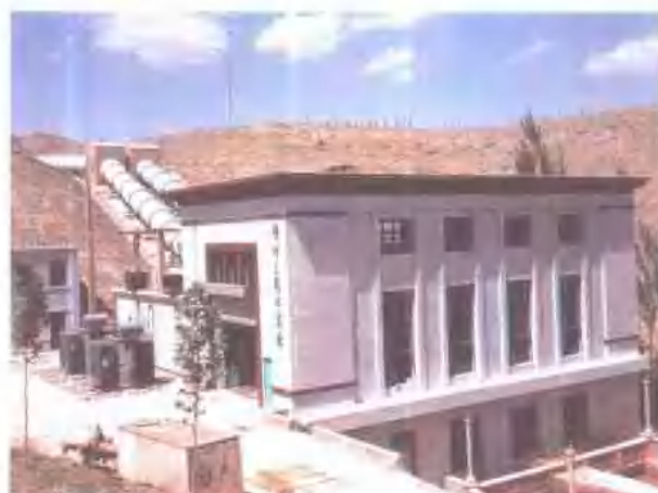
喀什地区三级水电站(装机 0.6 万千瓦)
