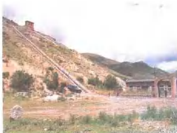
塔城地区马拉苏水电站(装机 0.15 万千瓦)
