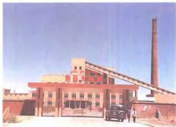
阿勒泰地区北屯电厂(装机1.2万千瓦)
