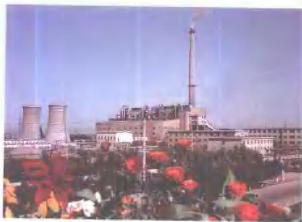
第一座公用热电厂——石河子热电厂(装机 2-4 万千瓦)
