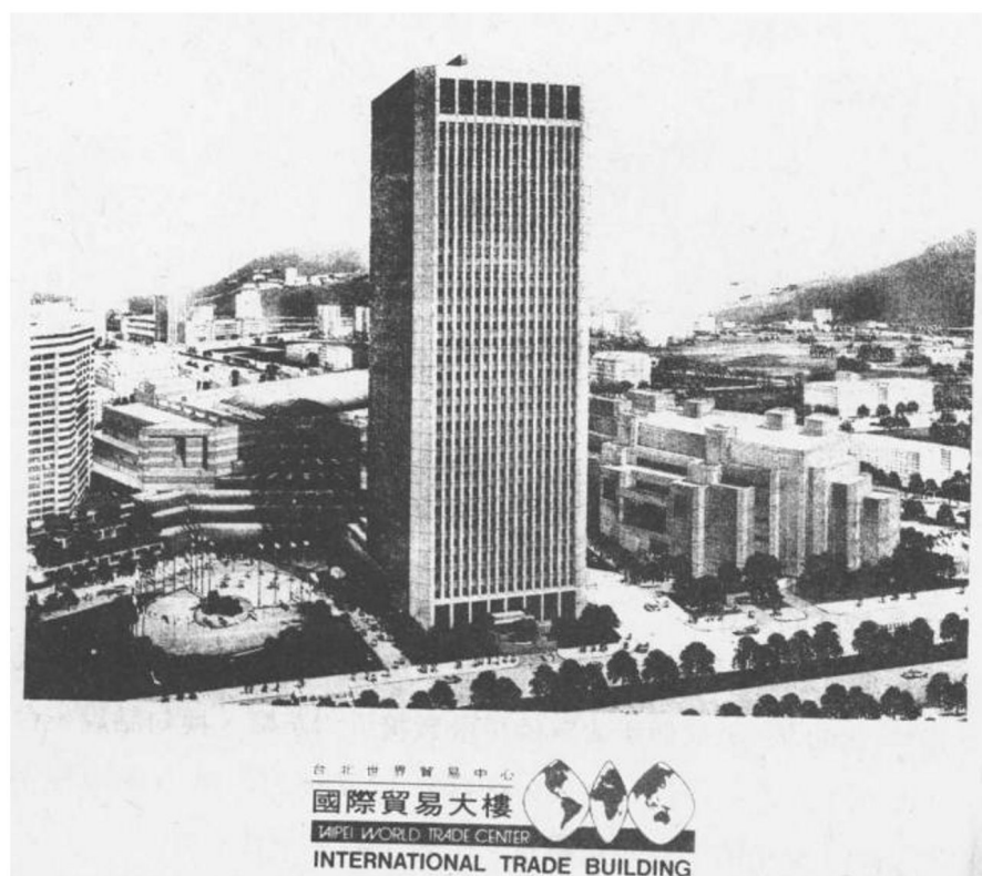
圖（1—1）：中興工程興建34層智慧型辦公國際貿易大樓
