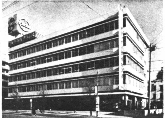
1961年完工の横浜営業所
