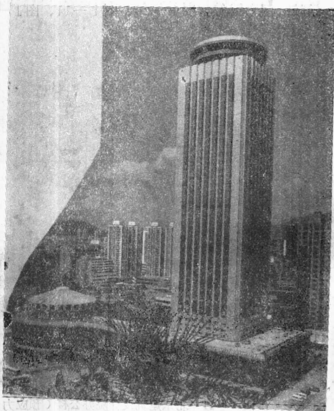
图 1—15 深圳国际贸易中心50层，160米，筒中筒结构
