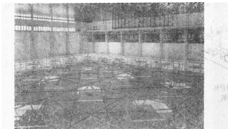
图1—6 a 上海体育馆练习馆网架结构
