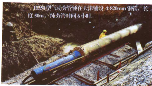
H350 型气动夯管锤在天津铺设 820mm 钢管，长度 50m，纯夯管时间 6 小时
