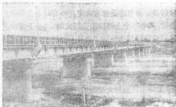
圖2 跨徑为30公尺的多孔梁式桥
