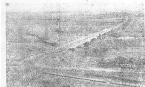
圖4 双懸臂上部構造萨拉河桥浮跨
