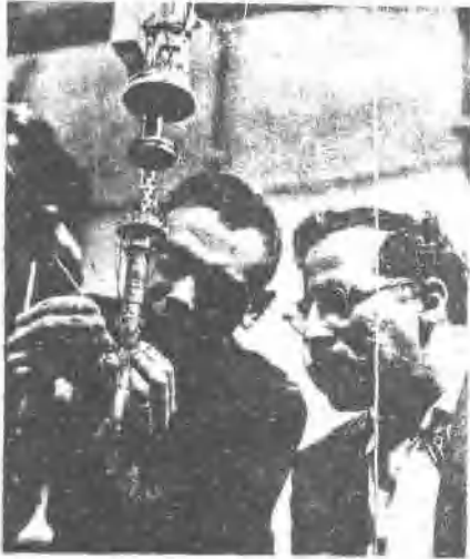
圖 3 兩位科學家正在檢查實驗室中的氦冷藏器，使溫度保持在絕對零度上 0.04 度。使用時，整套儀器都要被密封在真空箱中。
