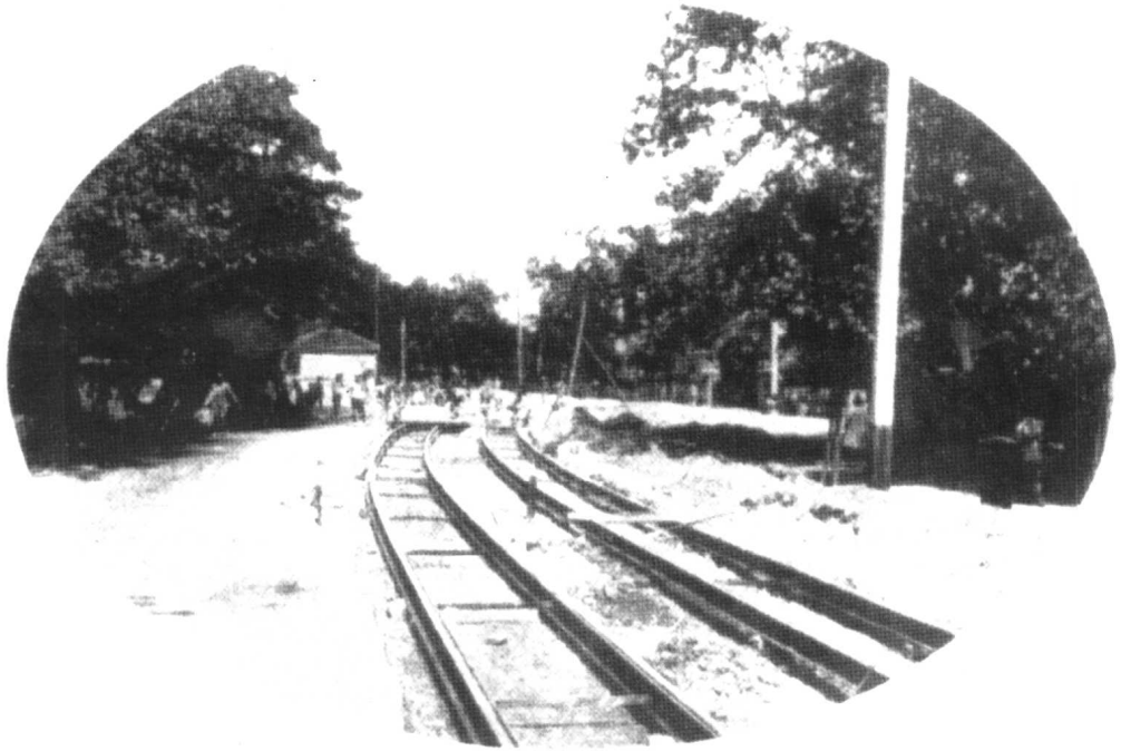
正在铺设电车轨道的静安寺路
