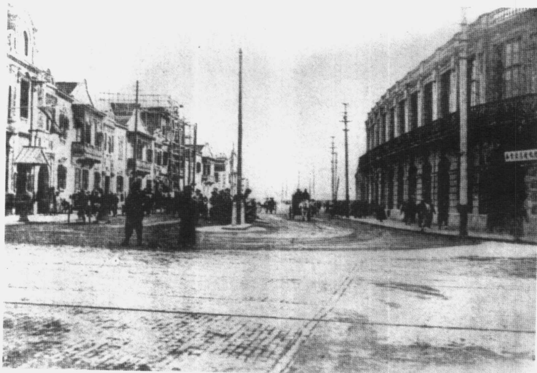
1915 年间泥城浜填没后筑的虞洽卿路(今西藏中路)
