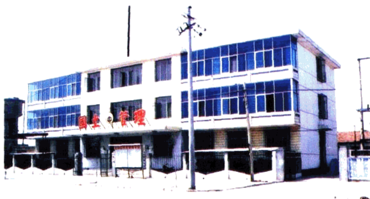
▶ 大城县土地管理局办公楼（1998年）
