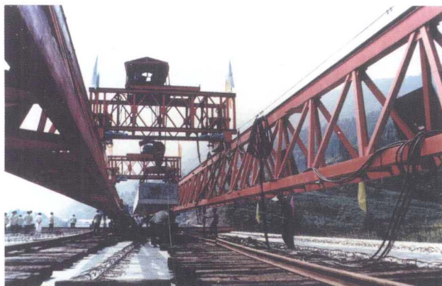
承建渝黔高速公路大桥
