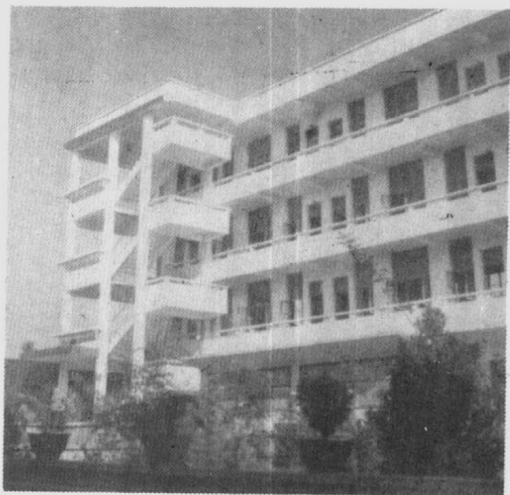
阆中师范学校新建的教学大楼
