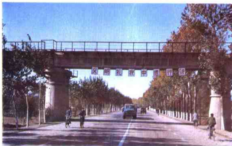
14 天津至秦皇岛线唐山市宽15米的水泥混凝土路面
