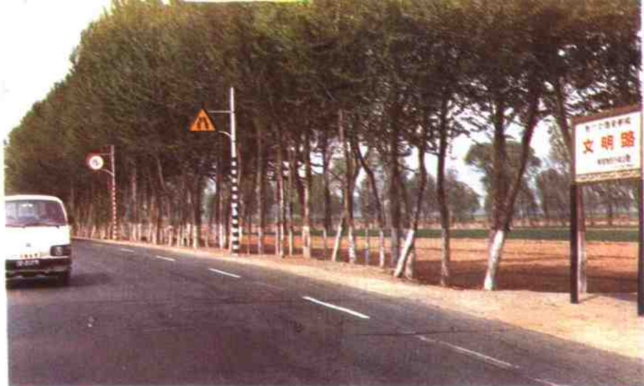
1 全国首创文明路的北京—磁县公路定县段，为全省、全国建设文明路活动起到先锋作用，受到交通部表彰
