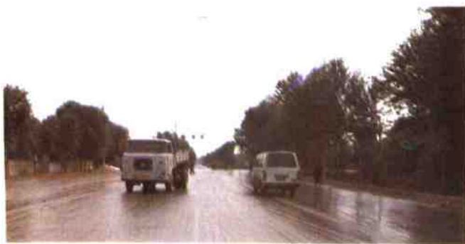
9 河北 最宽的油 路——津 保南线高 阳段，宽 25米
