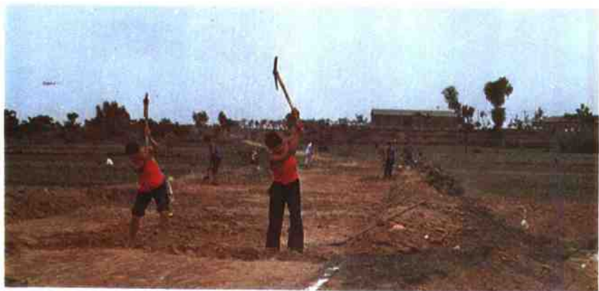
24 沙河民工建勤修建公路
