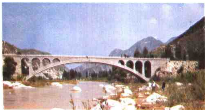
8 河 北跨径 最大的 石拱桥—— 平山界石 沟大桥， 跨径65 米
