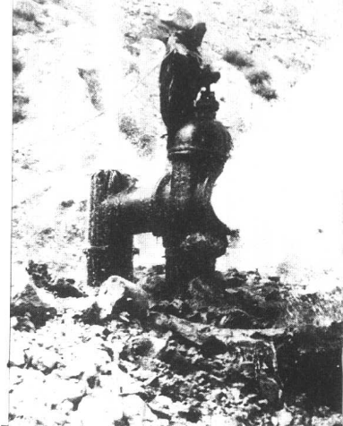
山西保德坑口电站铁匠铺水源地水源井之一
