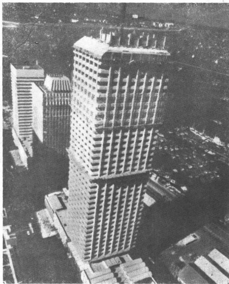
图1-8 新加坡40层办公楼具有8 in.厚后张30-ft跨平板。楼板厚度减薄后使楼的高度减少了40-ft（T·Y·Lin国际咨询公司）
