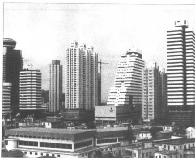
1980年8月，中国正式设立深圳、珠海、汕头、厦门四个经济特区，上图为建设中的深圳经济特区
