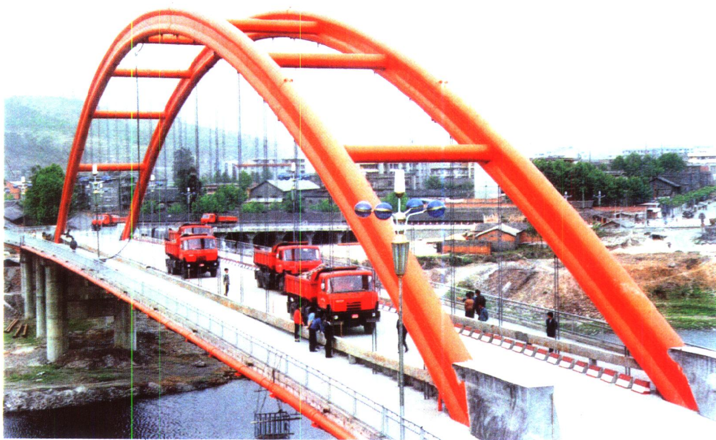
四川旺苍东河大桥
