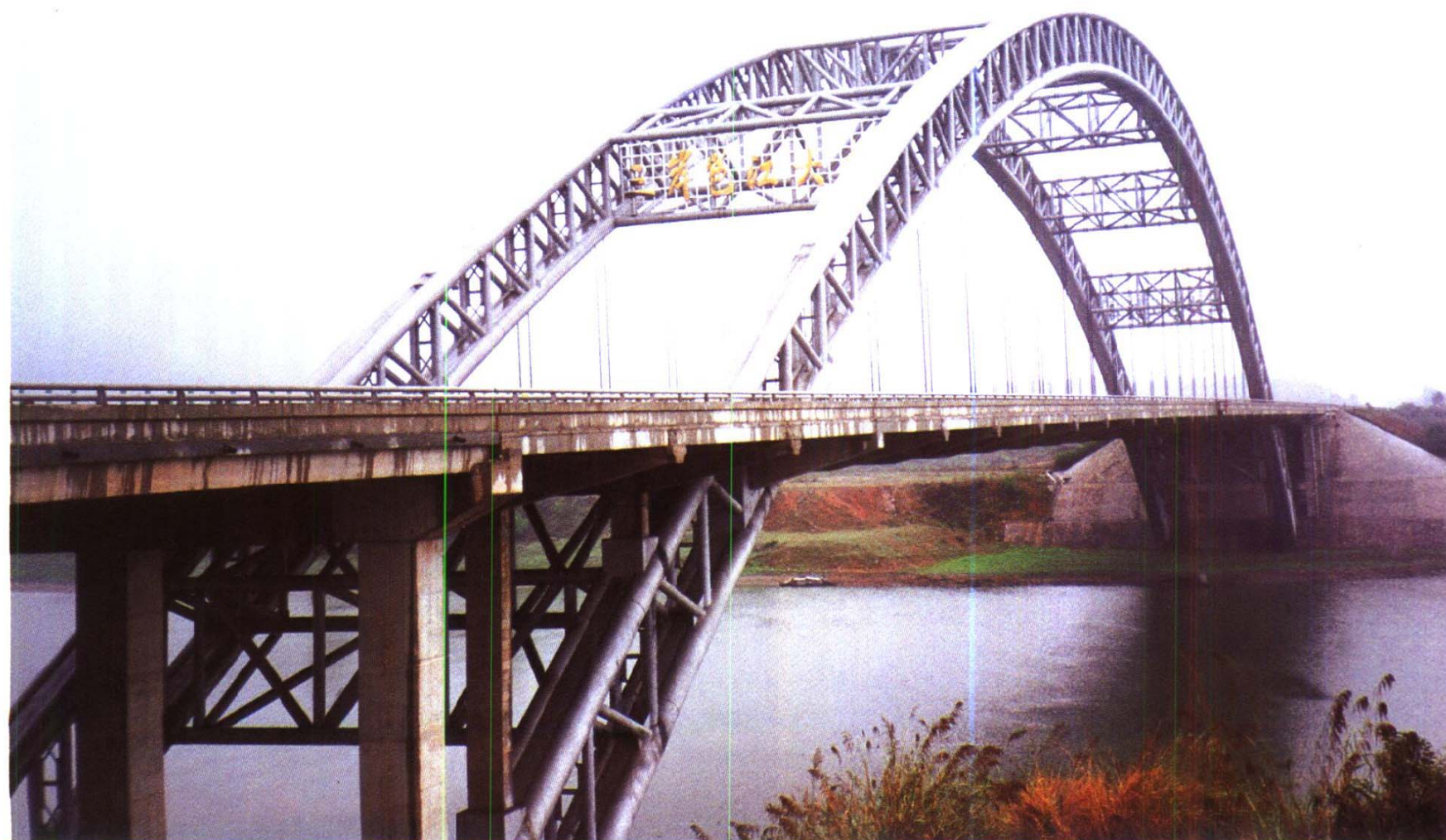
广西三岸邕江大桥
