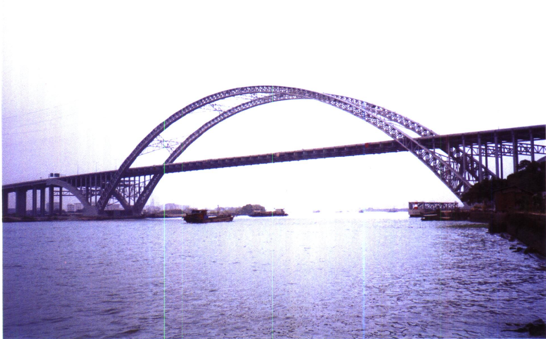
广州丫髻沙大桥
