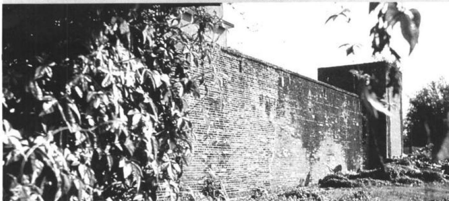
圖 1-3 吉慶圍的圍牆及砲樓，前面的綠草，原為護城河
