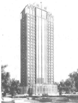
图1.8 哈尔滨市28层的百米配筋砌块砌体建筑
