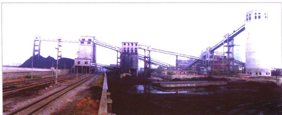
三河尖矿年产120万吨选煤厂(集团公司最大)
