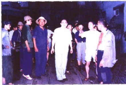
1990年2月26日江苏省副省长季允石(现省长)亲临韩桥矿察看该矿突水灾情,慰问矿工(前右起3)
