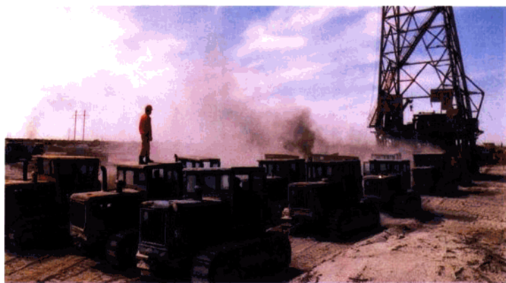
井架整体搬家
