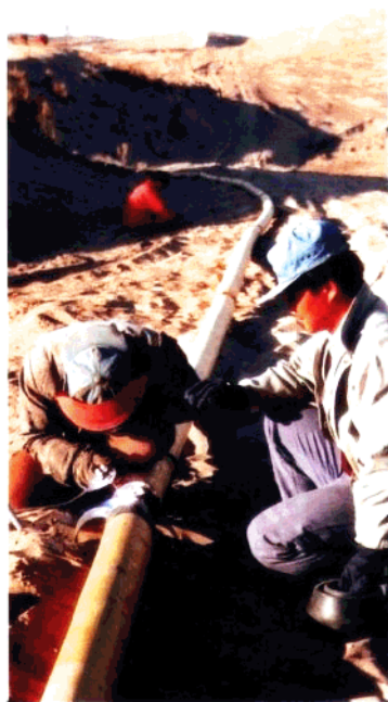
抢焊输气管线
