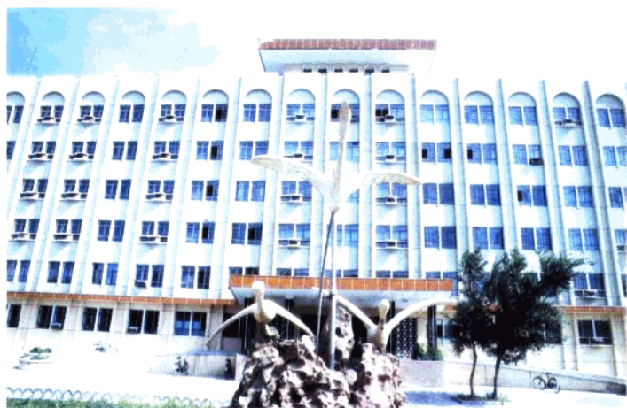
新疆石油管理局办公大楼
