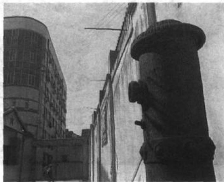
▲位于海南路上的20世纪初的消防栓。
