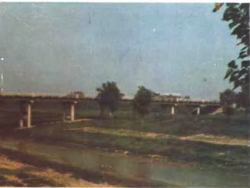
津保（南线）公路南赵扶大桥
