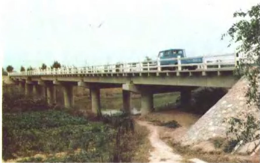
大城至里坦公路十里湾大桥
