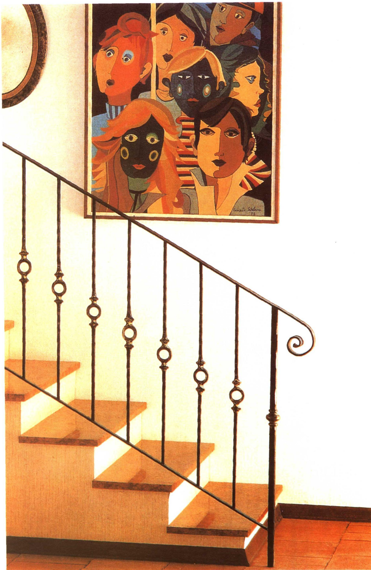
铁艺锻件基本单元: 900 × 60mm, \phi 12\text{mm}
