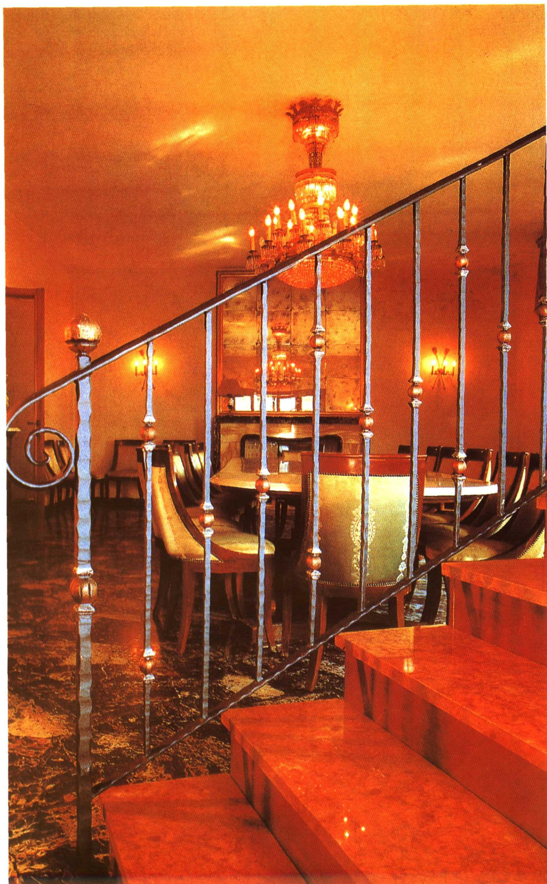
铁艺锻件基本单元: 900 × 40mm, 园球: \varnothing 40\text{mm} 立杆: 30 × 30mm (主) 16 × 16mm (次)
