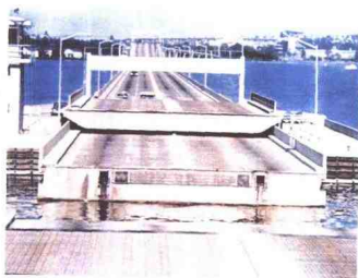
▲ 桥梁建设中,高强度预应力混凝土得到大量使用。
