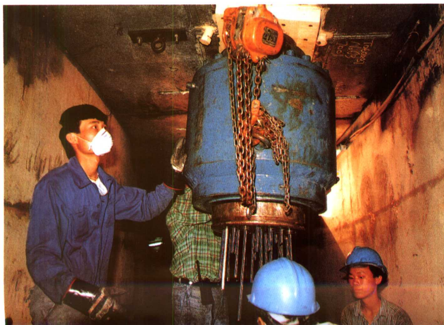
▲安全壳穹顶的预应力 钢丝束导管
