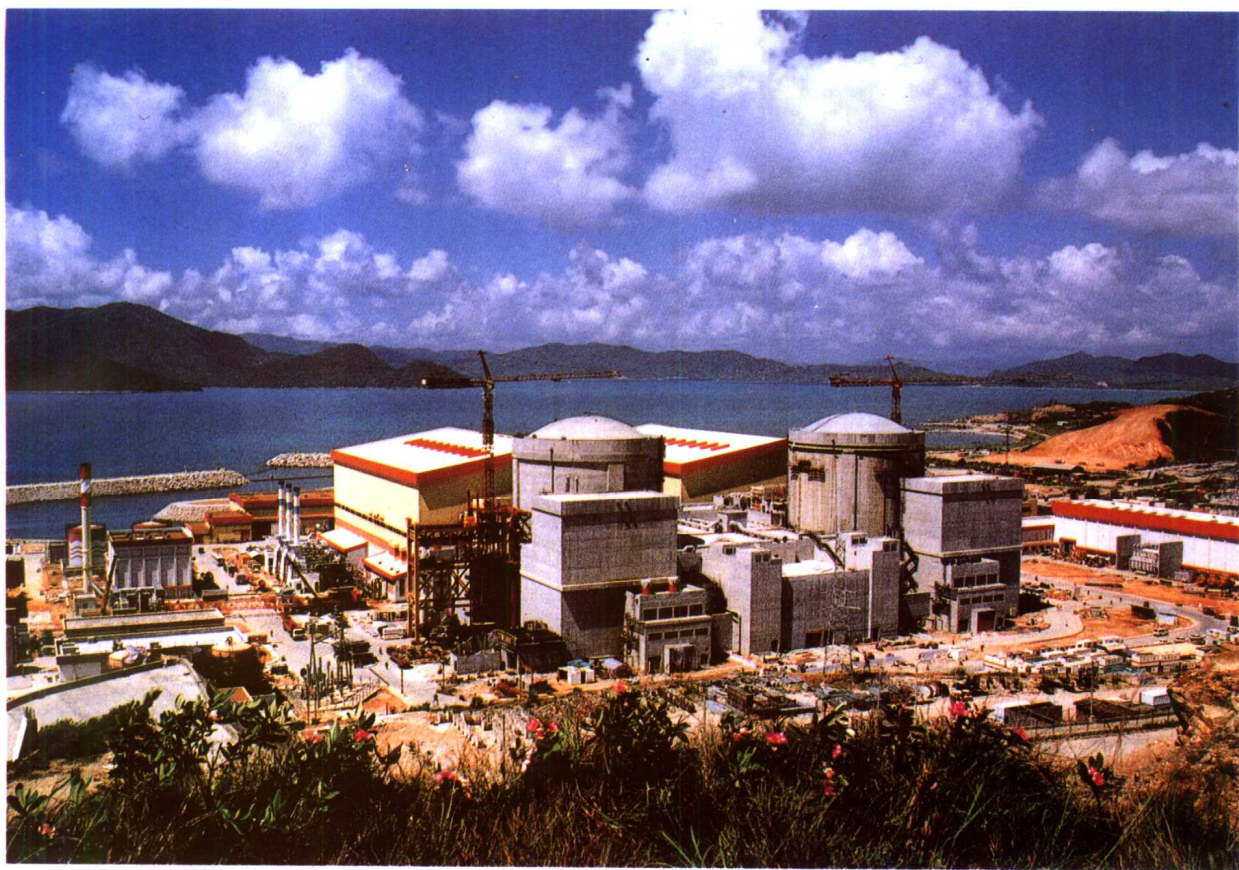
▲1991年6月土建主体工程已经完成时的全景 奚汉民摄
