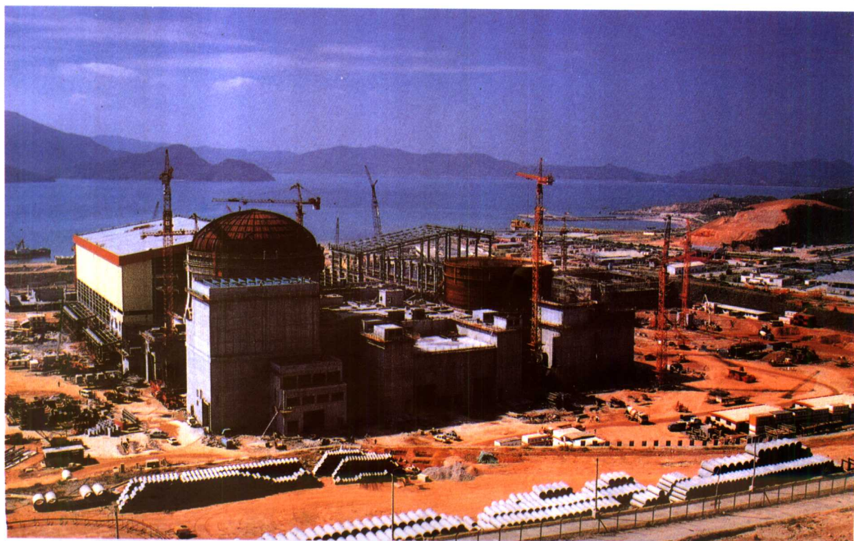
▼1989年10月大亚湾工地全景 奚汉民摄
