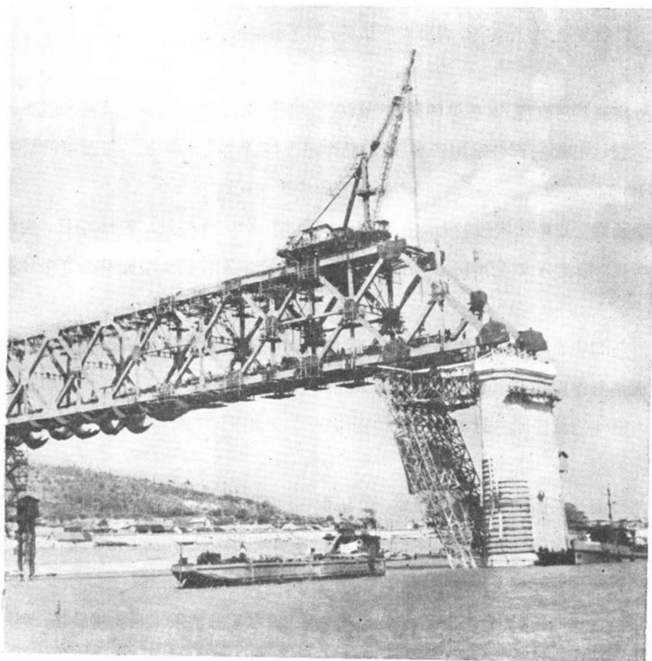
图 7 6 利用安裝托架架設鋼梁
