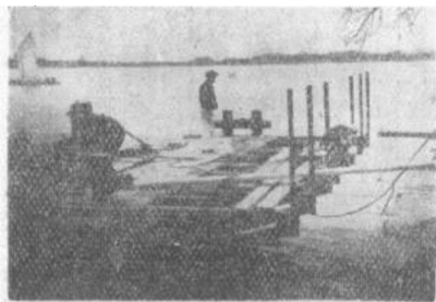
圖 12. 鐵趸船前後增設工作台
