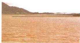
西江下游丁坝工程
