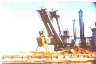
西江下游炸礁清淤工程施工现场
