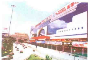
新建成的广深线上的深圳站外观
