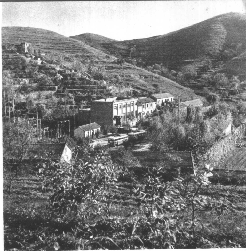
照片 11 红旗渠分水岭水电站
