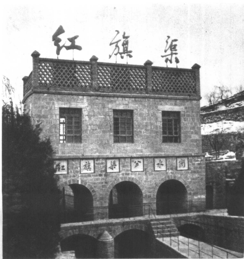
照片7 红旗渠分水闸
