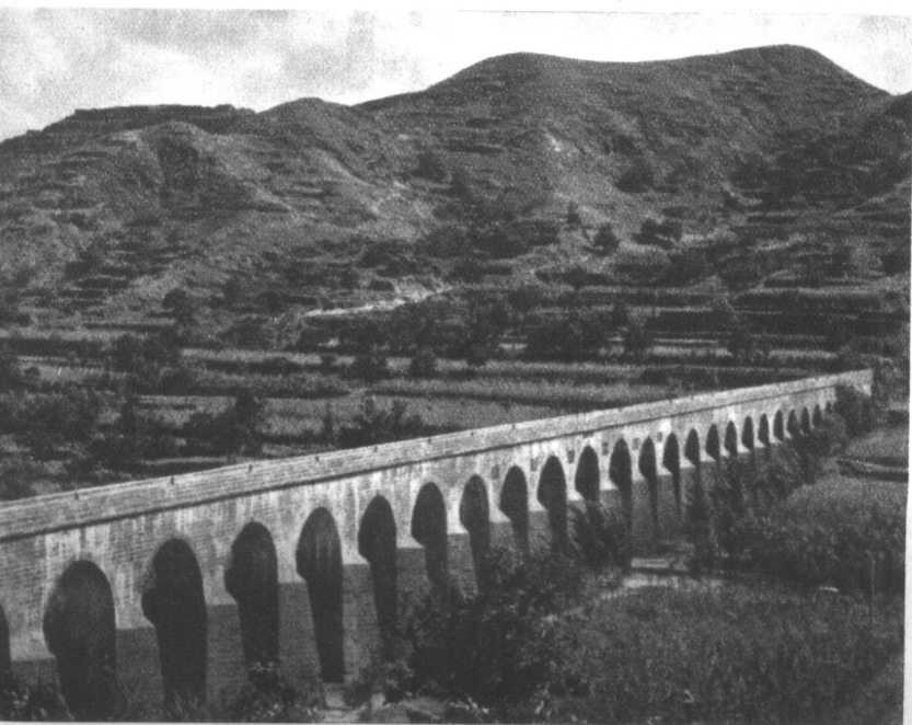
照片 13 丁冶岭曙光渡槽
