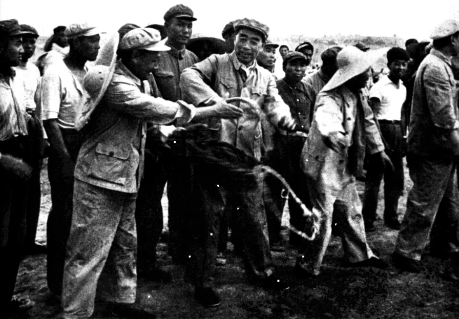
周恩來同志在水庫工地
