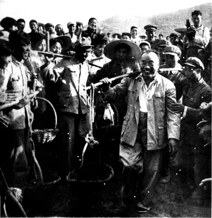
朱德同志在水庫工地
