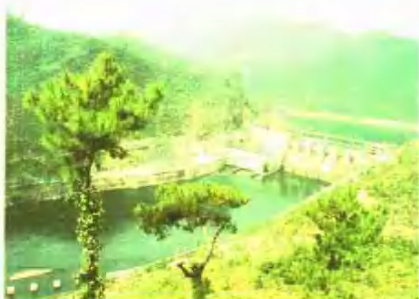
石门水电站，装机容量1.7万千瓦， 第一台机组于1974年9月建成发电
