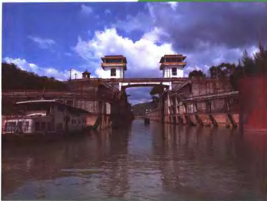
西津水电厂通航船闸，可通航 2\times 1000 吨级船队，1966年元月建成通航
