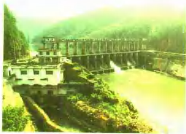
石门河二水电站，装机容量3100千瓦， 1974年10月建成发电
