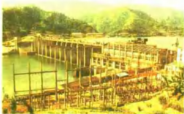
时庄水电站，装机容量10万千瓦， 第一台机组于1973年10月建成发电
