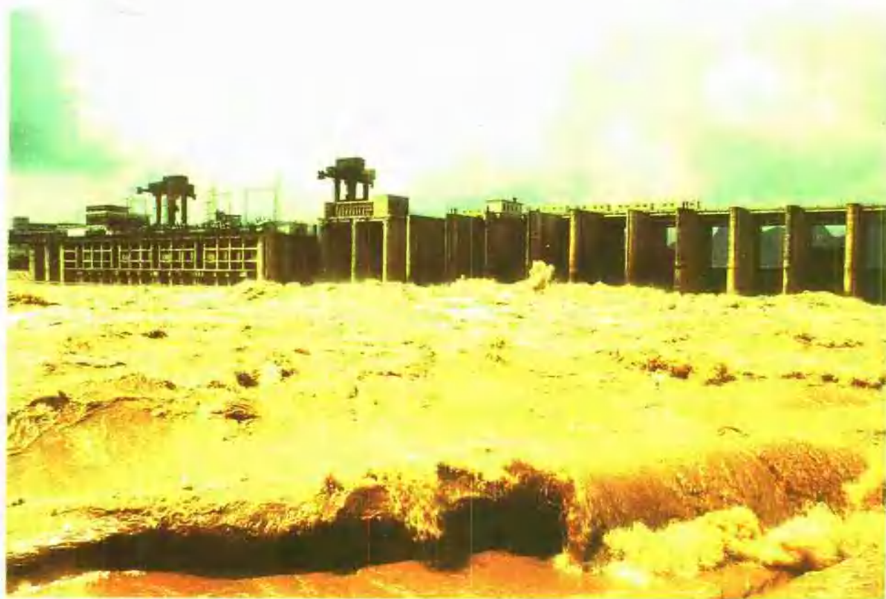
红水河大觉水电站，装机 4 \times 10 万千瓦，1983年12月第一台机组建成发电
