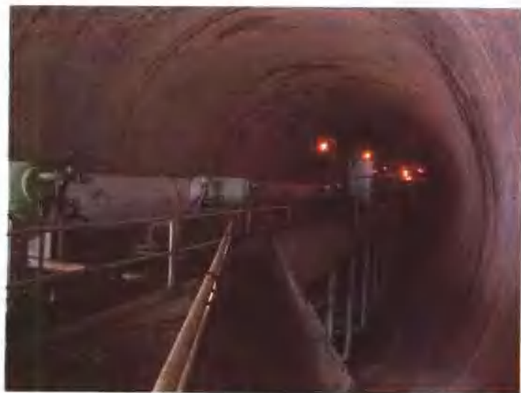
天生桥水电站引进美国的 10.8 米全断面掘进机，正进行隧洞开挖
