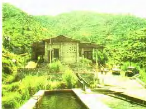
石门河水电站厂房自奉水电站建于1944年， 装机容量1030千瓦
