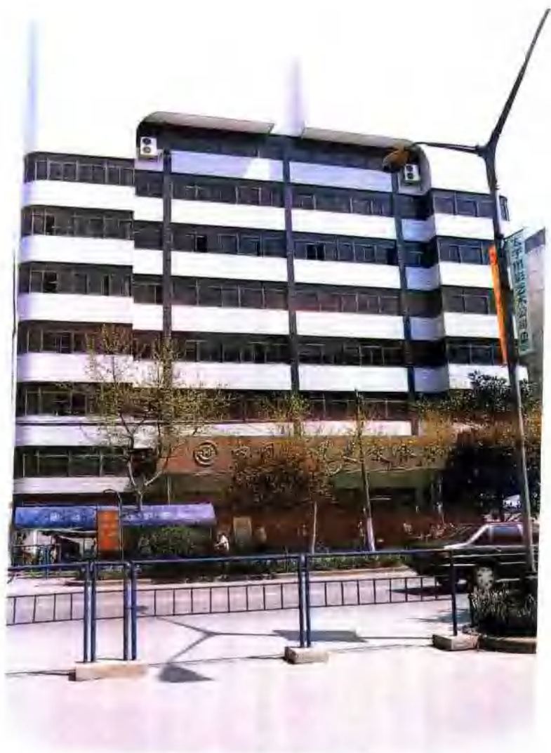
中国建设银行嘉兴市分行办公大楼外貌。
