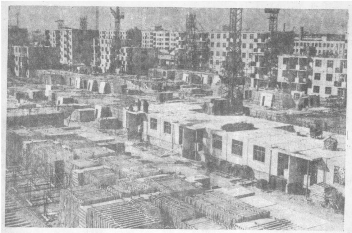
图 II-0-1 装配式建筑工地现场
