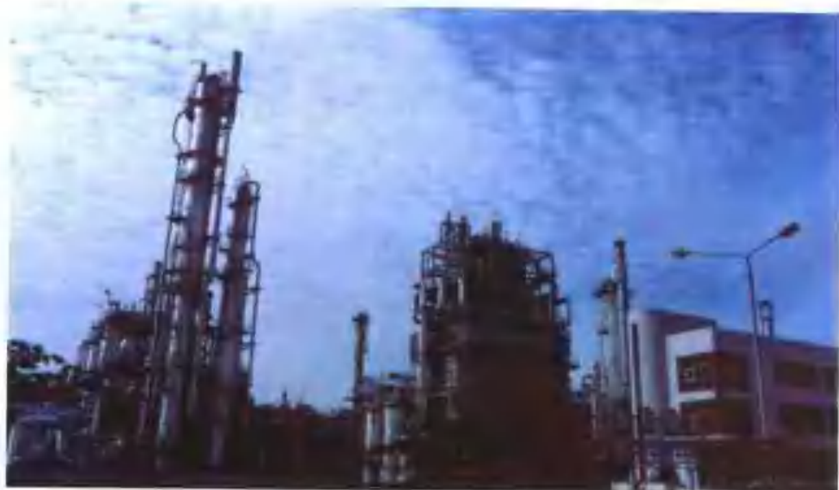
中海石油化学公司海南富岛 化肥生产装置
