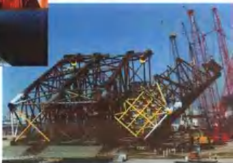
建造海上平台导管架
