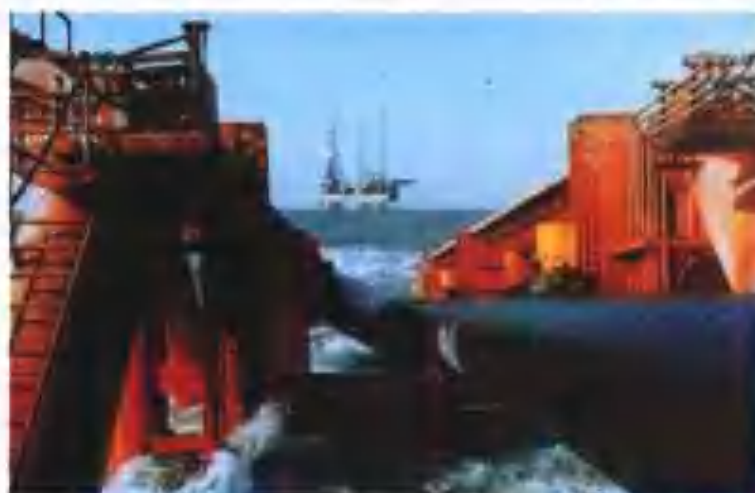
海上铺管作业
