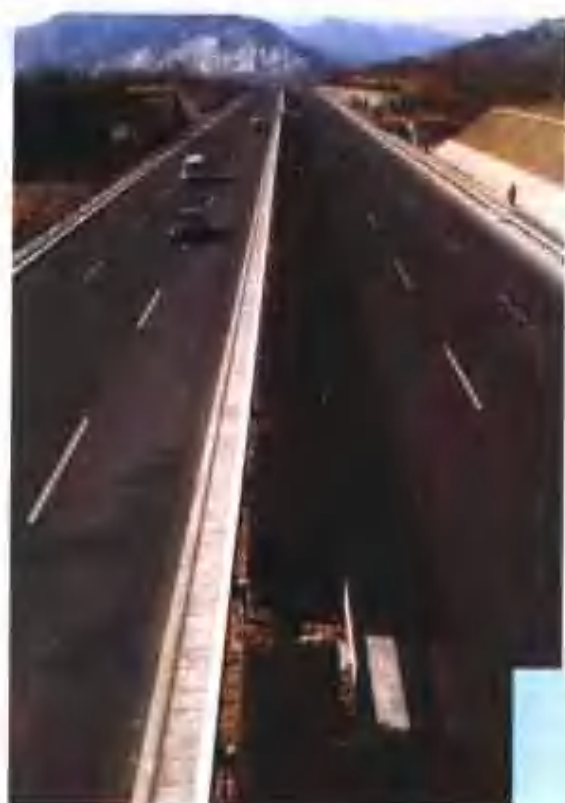
中海 36-1 高级沥青铺设 的高速路
